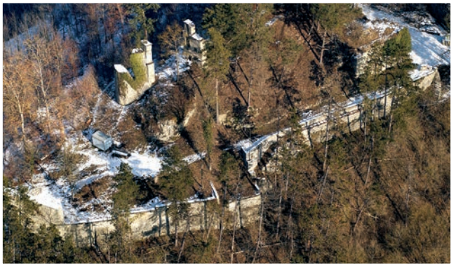
Luftbild der Gesamtanlage aus dem Jahr 2005
